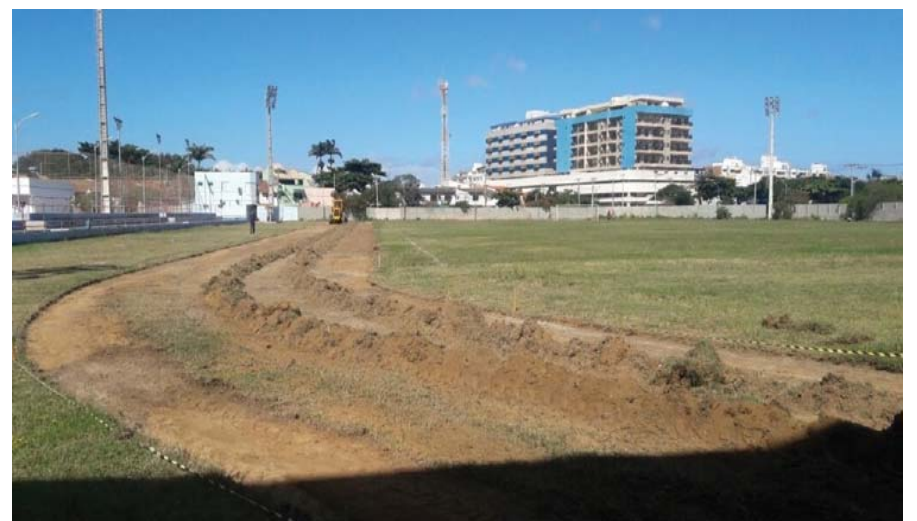
Portal da Prefeitura de Cabo Frio
